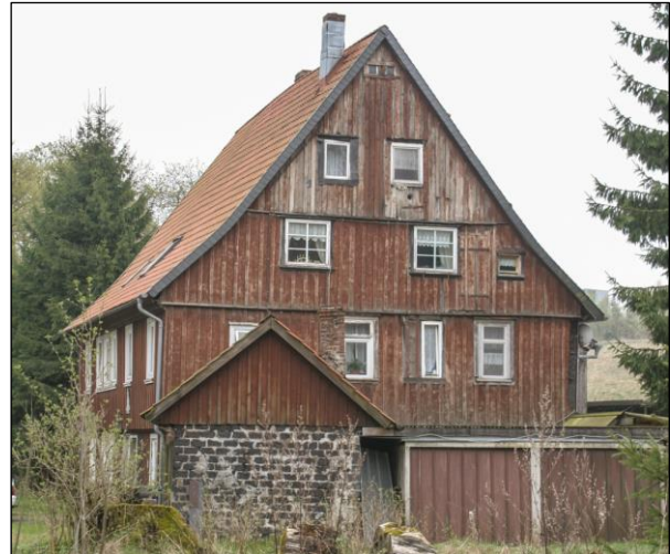
Clausthal, Altenauer Str. 18. Ludwiger Zechenhaus, 17. Jh. Foto: A. Schmid-Engbrodt
