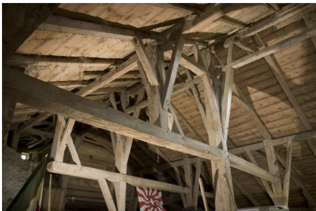
Firstständer-Dachkonstruktion. Bäuerlicher Vieltweckbau von 1621/24 in Renan, Envers des Convers 87. Foto: Jacques Bélat
